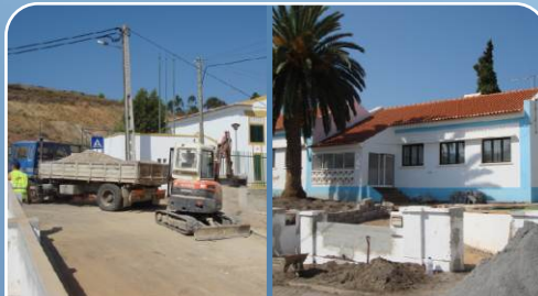
SABÓIA - REPARAÇÃO DA ESCOLA E ARRUAMENTOS ENVOLVENTES
