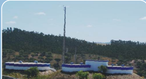
SABÓIA - REFORÇO DO ABASTECIMENTO DE ÁGUA E NOVO DEPÓSITO
